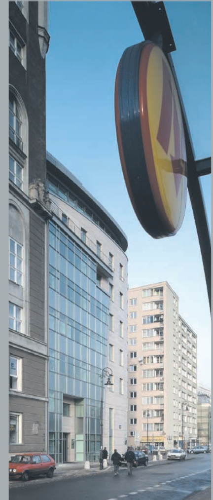
Widok od ulicy Zielnej. View from Zielna Street. Ansicht von der Zielna Straße aus.
