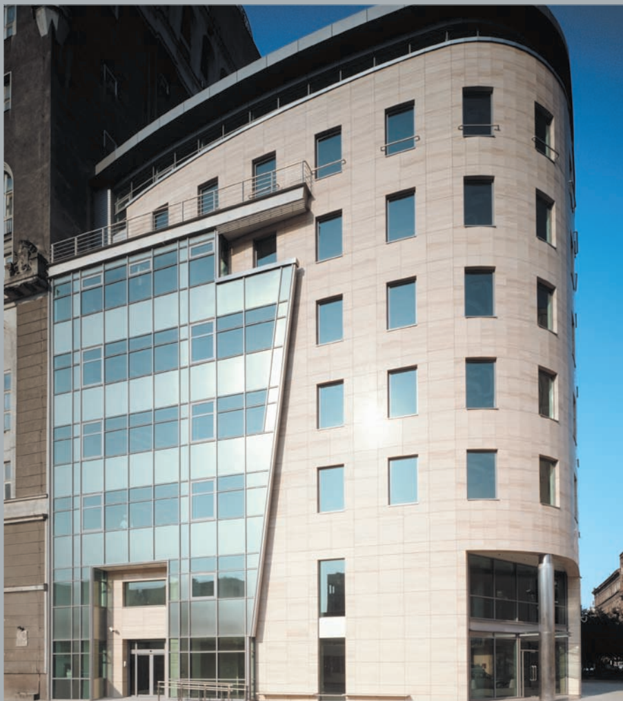
Widok od ulicy Zielnej. View from Zielna Street. Ansicht von der Zielna Straße aus.
