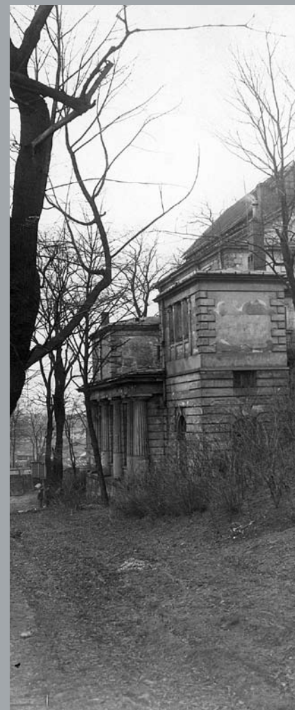
Willa Bohdana Pniewskiego. Bohdan Pniewski's villa. Villa von Bohdan Pniewski.
