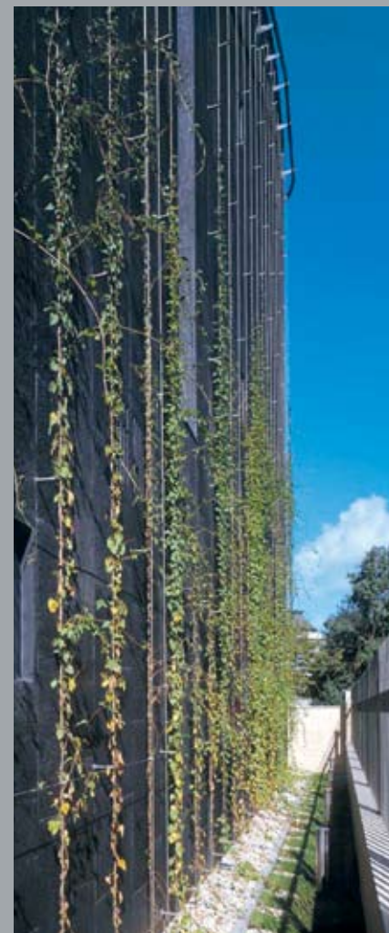
Rośliny pnące na ścianie wschodniej. Rambling plants on the wall. Schlingpflanzen an der Ostwand.
